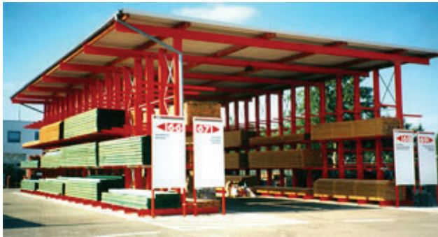
Fuente: http://www.ohra.es/default.aspx?pagename=Bsp_Bauholzlagerung Figura 27. Almacenaje de madera de construcción en un almacén exterior
