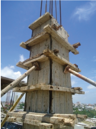
Fuente: www.cmm.com Figura 1. Uso temporal en columnas
