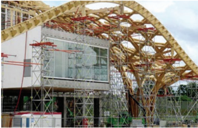
Fuente: maderadisegno Figura 51. Estructura Lamelar
