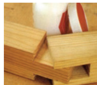
Fuente: www.teycubermadera.com Figura 42. Empalme a espiga.
