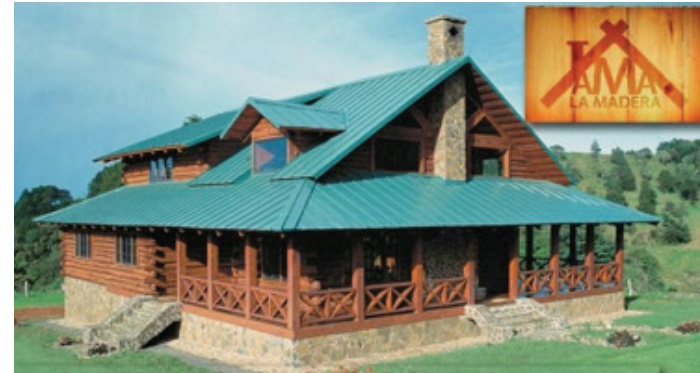
Cabaña Fraijanes, Alajuela. 450 m2. Mención Honorífica y Finalista Bienal CFIA-Metalco 2004. amalamadera@racsa.co.cr / www.amalamadera.com José Antonio Flores Sibille, arquitecto.
