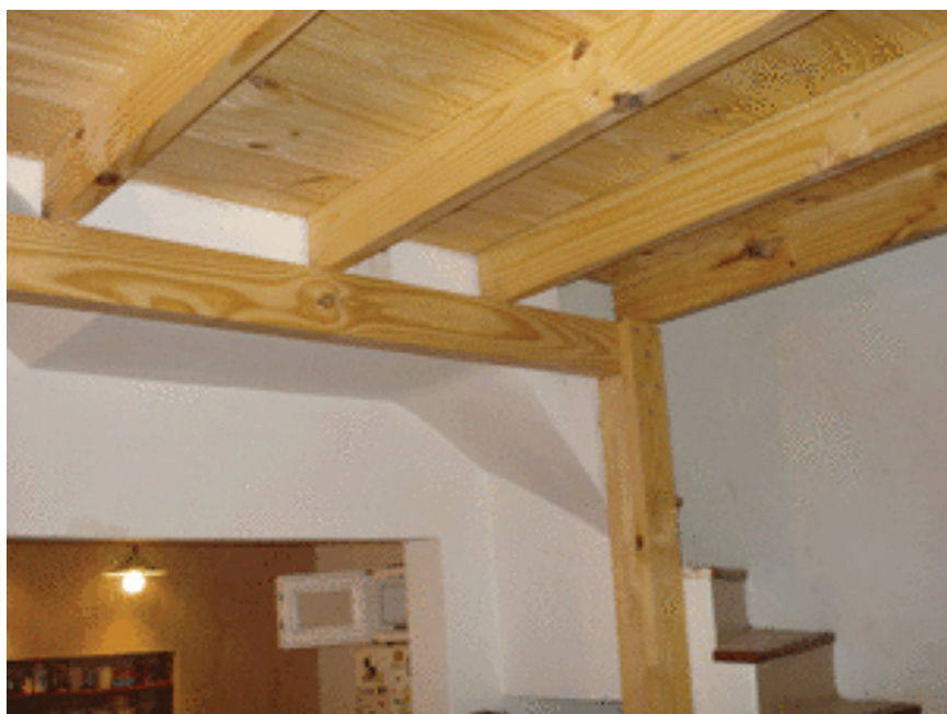
Fuente: www.proyectos.habitissimo.es Figura 53. Viga sobre pilar segundo piso
