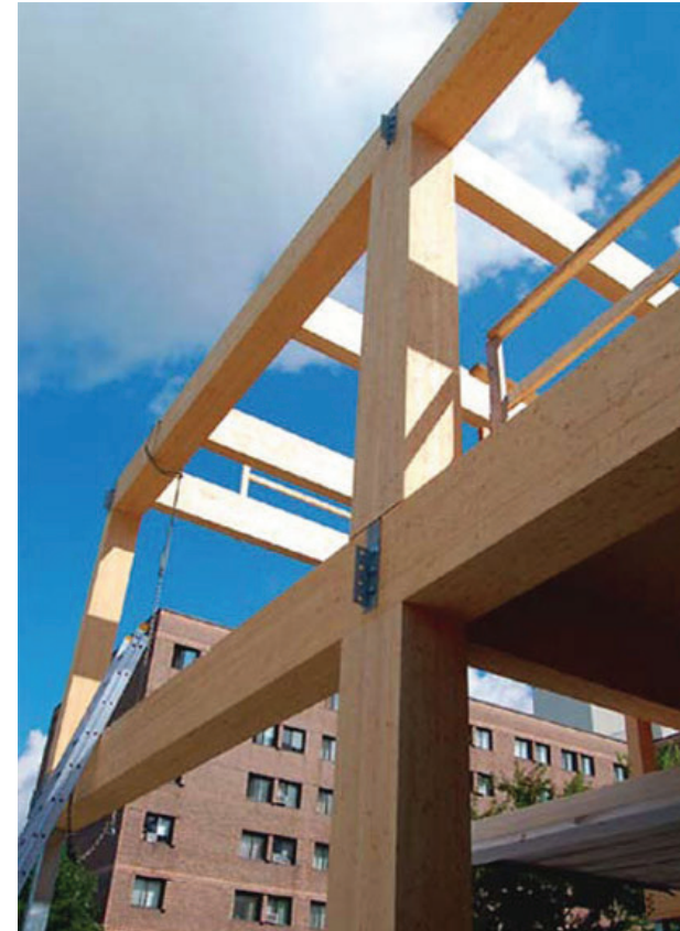
Fuente: www.cadamda.org.org Figura 52. Viga sobre pilar
