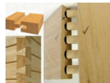
Fuente: www.teycubermadera.com Figura 41. Empalme con tarugos y cola de milano
