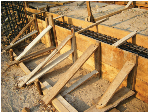
Fuente: www.arquienguate.blogspot.com Figura 3. Uso temporal en formaleta
