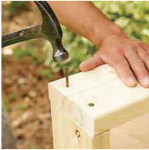
Fuente: www.guiademanualidades.com Figura 27. Uniones con clavos.
