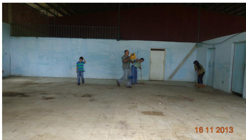
Habilitando una bodega en desuso
