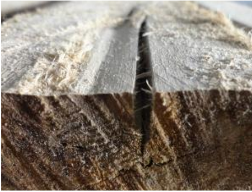
Grieta por cabeza Foto: INTECO, 2018
