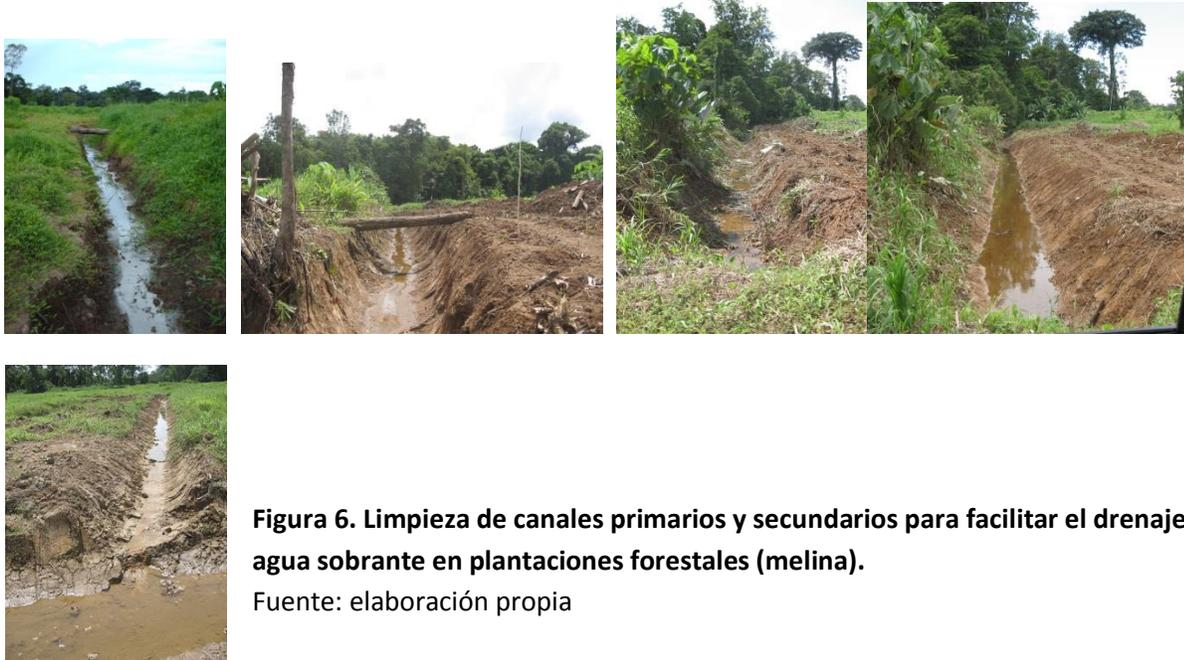
**Figura 6. Limpieza de canales primarios y secundarios para facilitar el drenaje del agua sobrante en plantaciones forestales (melina).**
